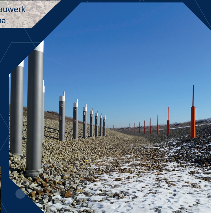
Bau Überleiter 11 inkl. Dalben Großräschener See
