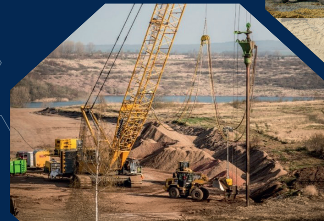
Rütteldruckverdrichtung Nachterstedt
