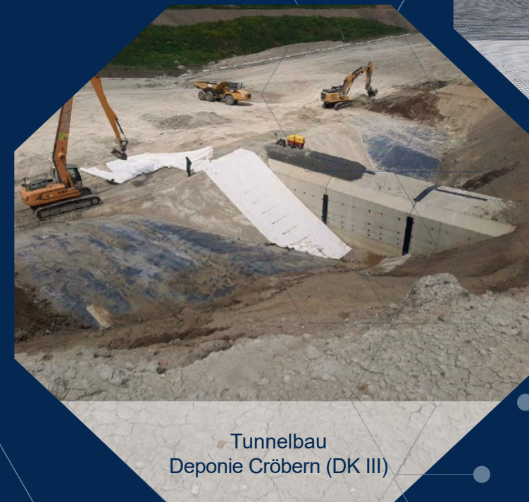
Kunststoffdichtung Deponie Cröbern (DK III)
