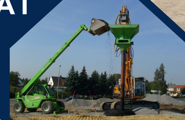
Rüttelstopfverdrichtung Lauchhammer
