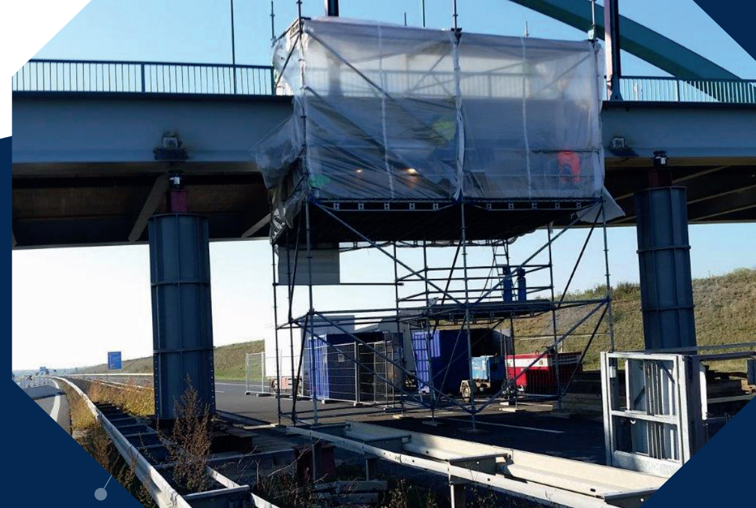
Reparatur und Montage vor Ort
